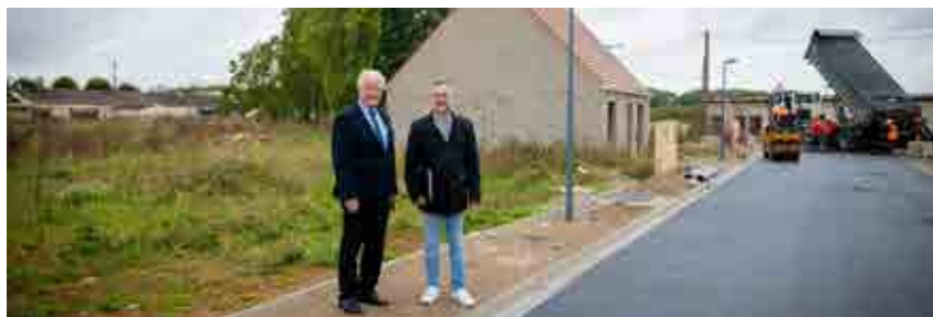
Terrains viabilisés et enrobage terminés, le site de L'Orée des champs poursuit sa transformation comme ont pu le constater Jean-Michel Poisson et Ludovic Esnault, responsable programme de la SPL, en visite sur le chantier mi-octobre.
