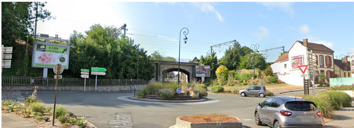
Intersection entre les départementales RD954 et RD34
