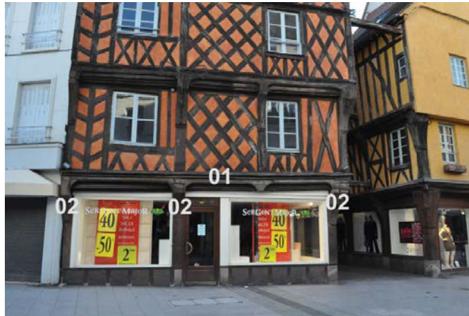
Exemple de devanture dans une façade à colombage
