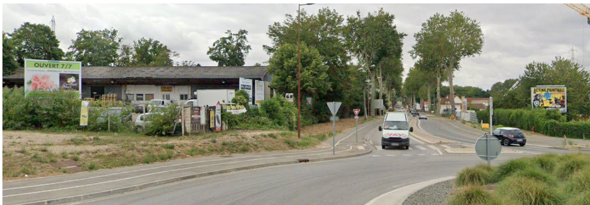
Entrée est de la commune
