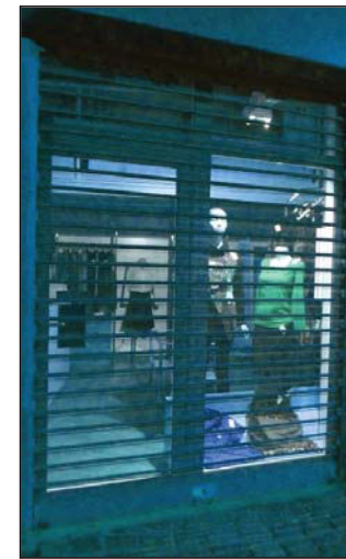
Rideau métallique microperforé laissant voir l'intérieur de la vitrine
