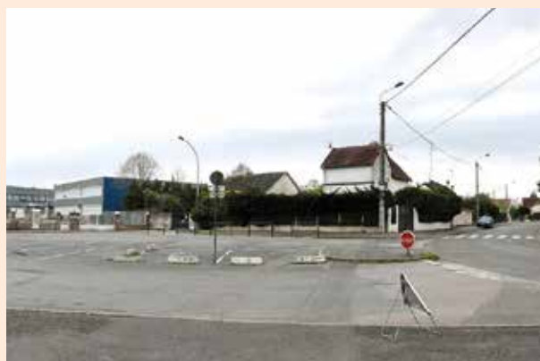
Le parvis du collège Louis-Armand avant travaux.
