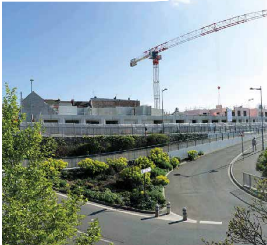
NPNRU : 40 logements sociaux en construction
