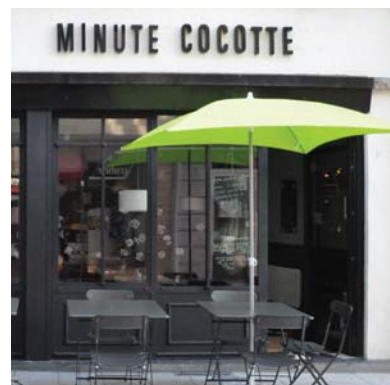
Les lettres individuelles sur enduit
