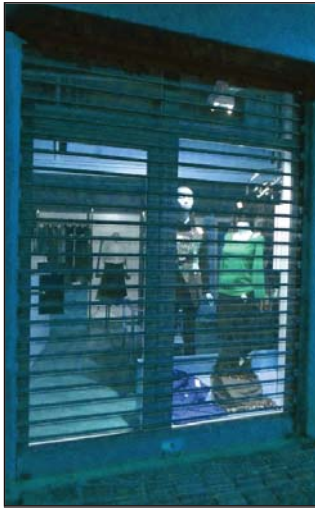
Rideau métallique micropéré laissant voir l'intérieur de la vitrine
