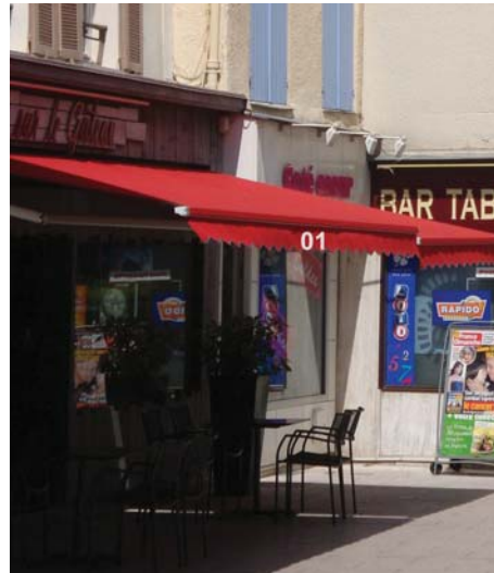
Store de type «banne», droit et pliant, en toile textile unie, avec lambrequin (01)
