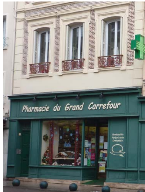
Exemple de devanture dans une façade avec modénature
