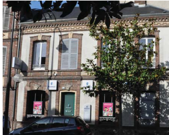
Exemple de devanture dans une façade en brique
