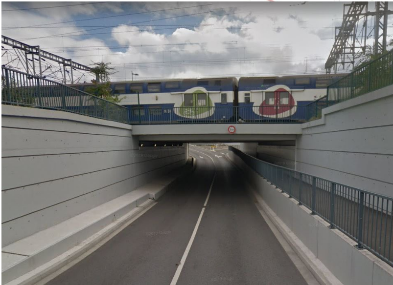
Source : Passage sous la voie ferrée
