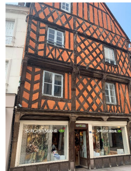
Maison à pan de bois Source : VE2A avril 2022
