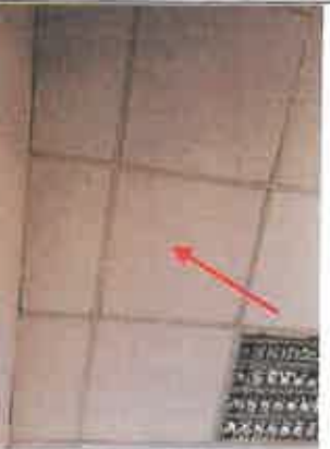
Photo n° PhA014 Localisation : Bureau 1 Ouvrage : 4 - Plafonds et faux plafonds - Faux plafonds Partie d'ouvrage : Panneaux et plaques Description : Panneaux et plaques
