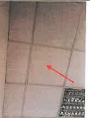
Photo n° PhA022 Localisation : PL9 Ouvrage : 4 - Plafonds et faux plafonds - Faux plafonds Partie d'ouvrage : Panneaux et plaques Description : Panneaux et plaques
