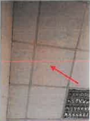
Photo n° PhA016 Localisation : Bureau 3 Ouvrage : 4 - Plafonds et faux plafonds - Faux plafonds Partie d'ouvrage : Panneaux et plaques Description : Panneaux et plaques
