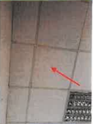
Photo n° PhA017 Localisation : Douches Ouvrage : 4 - Plafonds et faux plafonds - Faux plafonds Partie d'ouvrage : Panneaux et plaques Description : Panneaux et plaques
