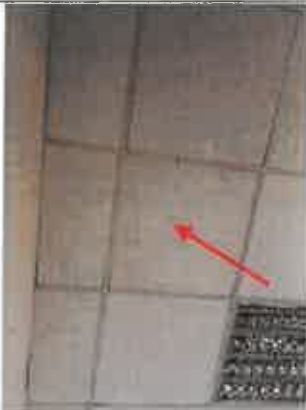
Photo n° PhA015 Localisation : Bureau 2 Ouvrage : 4 - Plafonds et faux plafonds - Faux plafonds Partie d'ouvrage : Panneaux et plaques Description : Panneaux et plaques
