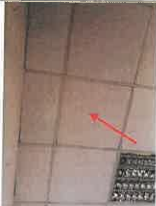
Photo n° PhA019 Localisation : Vestiaire 2 Ouvrage : 4 - Plafonds et faux plafonds - Faux plafonds Partie d'ouvrage : Panneaux et plaques Description : Panneaux et plaques
