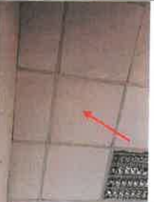
Photo n° PhA021 Localisation : Bureau 4 Ouvrage : 4 - Plafonds et faux plafonds - Faux plafonds Partie d'ouvrage : Panneaux et plaques Description : Panneaux et plaques
