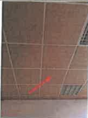
Photo n° PhA011 Localisation : Salle de pause Ouvrage : 4 - Plafonds et faux plafonds - Faux plafonds Partie d'ouvrage : Panneaux et plaques Description : Panneaux et plaques
