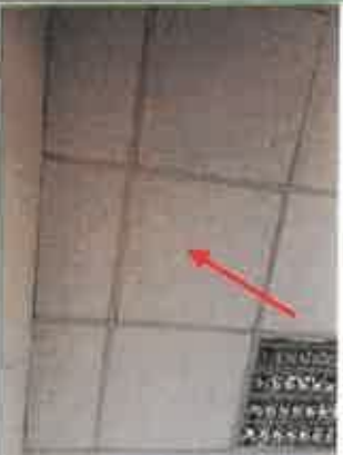
Photo n° PhA010 Localisation : Salle Ouvrage : 4 - Plafonds et faux plafonds - Faux plafonds Partie d'ouvrage : Panneaux et plaques Description : Panneaux et plaques
