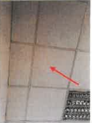
Photo n° PhA018 Localisation : Vestiaire 1 Ouvrage : 4 - Plafonds et faux plafonds - Faux plafonds Partie d'ouvrage : Panneaux et plaques Description : Panneaux et plaques
