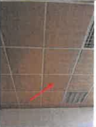
Photo n° PhA009 Localisation : Local Vélo Ouvrage : 4 - Plafonds et faux plafonds - Faux plafonds Partie d'ouvrage : Panneaux et plaques Description : Panneaux et plaques
