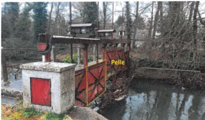
Ouvrage principal de l'Usine des eaux (vue amont)
